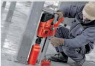
Hiter in natančen: Izvrtine skozi zid za cevi ogrevanja in vodovoda.
