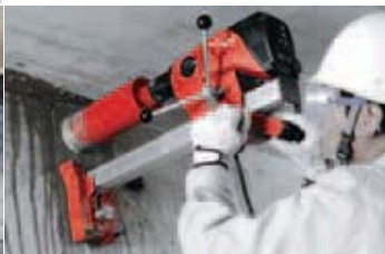
Preboji za prezračevalne kanale in kabselske trase.
